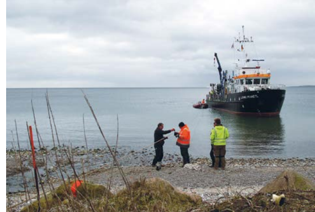
Mit Hilfe des Küstenforschungsschiffs LUDWIG PRANDTL vom HZG wird der Landanschluss für das Observatorium gelegt. Fotos: Forschungstaucherzentrum CAU
