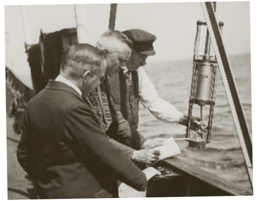
Probenahme an Bord der Poseidon mit einem Wasserschöpfer
